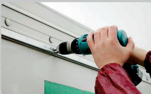
Vorbohren 4,8 mm
